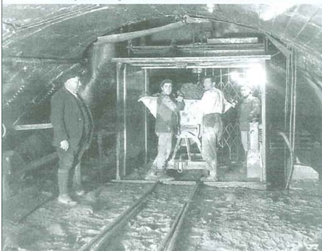
Túnel y montacargas en el Canal de las Bardenas, 1934.
